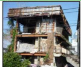
・外壁が剥落し、アスベスト飛散のおそれ
