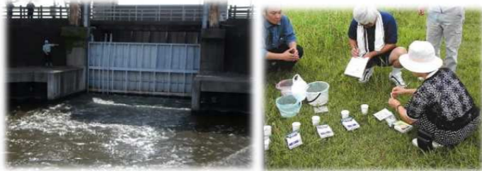
水門の開閉実験 市民主体の水質調査 (水質改善への第一歩)
