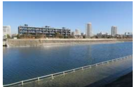
図9 新町地域の水辺テラス水没箇所
