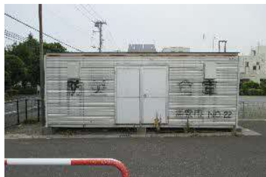
【コンテナ式防災備蓄倉庫】
