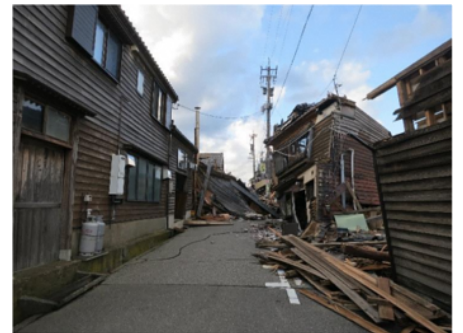
焼失した区域周辺の様子
