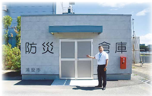
プレハブ式の防災備蓄倉庫
