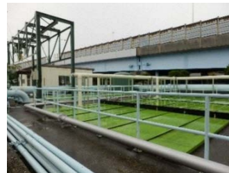
【舞浜ポンプ場(全体)】
