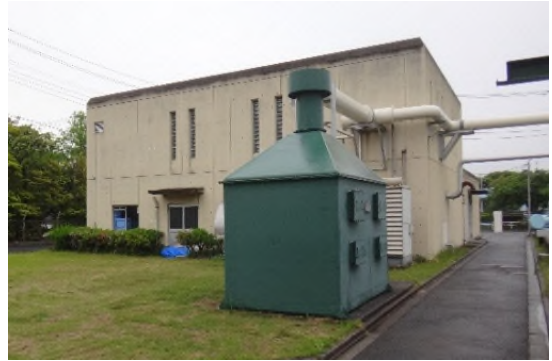
【図表 1-1】 建設後、約40年が経過するポンプ場管理棟
