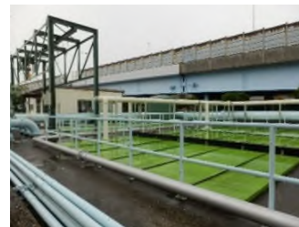
【舞浜ポンプ場(全体)】
