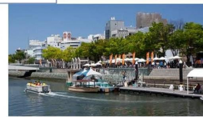
親水護岸の利用 （新町川／徳島市）
