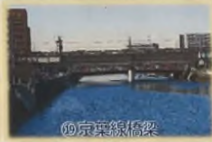
⑲京葉線橋梁
