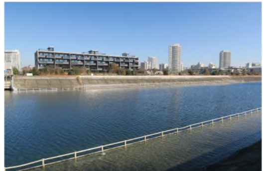
図9 新町地域の水辺テラス水没箇所
