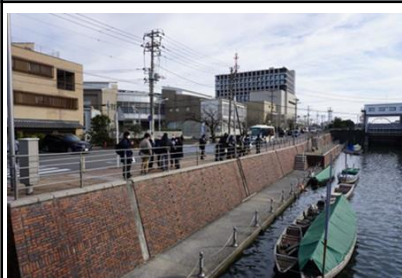
まち歩き Cゾーン左岸（猫実側） 平成27年度修景整備済
