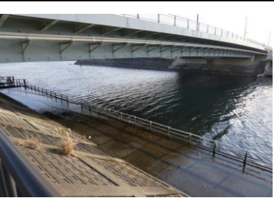
D 2 ゾーン左岸 (明海側) (日の出橋上流側)
