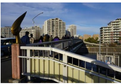
D2ゾーン (明海橋)
