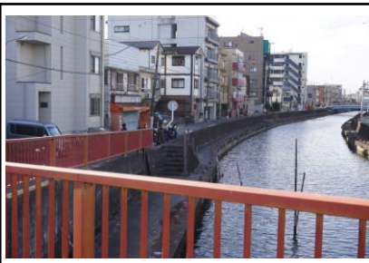
Aゾーン（新橋上流側）
