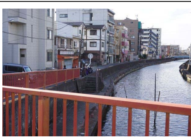
Aゾーン（新橋上流側）
