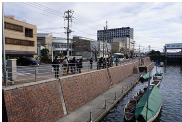
まち歩き Cゾーン左岸（猫実側） 平成27年度修景整備済
