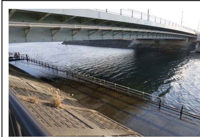
D 2 ゾーン左岸（明海側） （日の出橋上流側）
