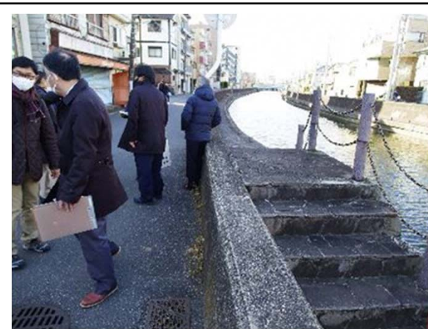
Aゾーン（新橋上流側） 親水施設へのアクセス階段
