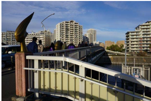
D2ゾーン（明海橋）
