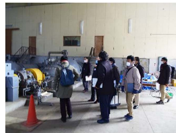
D1-1ゾーン 境川排水機場（内部）
