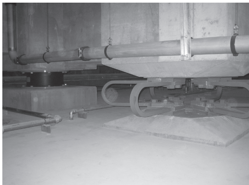
消防庁舎 1 階床下基礎免震部
