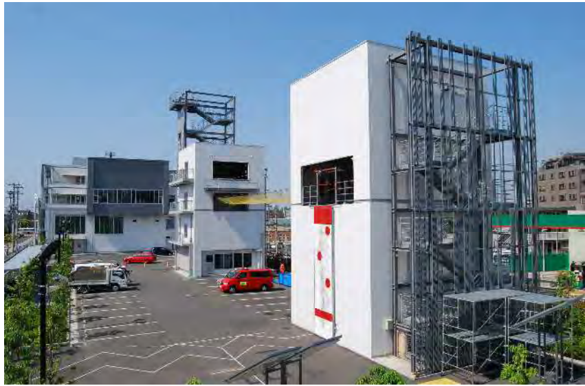
消防庁舎訓練塔
