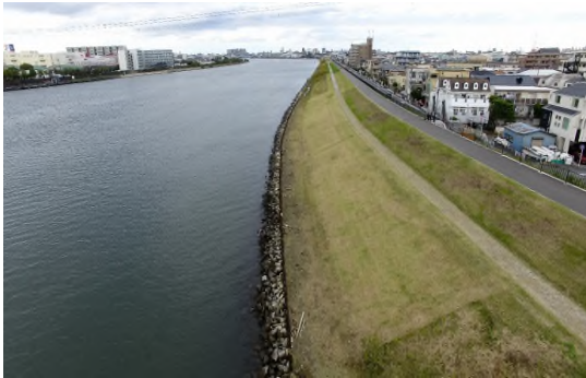
開放された旧江戸川緩傾斜護岸 (富士見 2 丁目から堀江橋付近)
