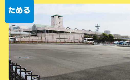
東野パティオにあるオンサイト貯留施設
