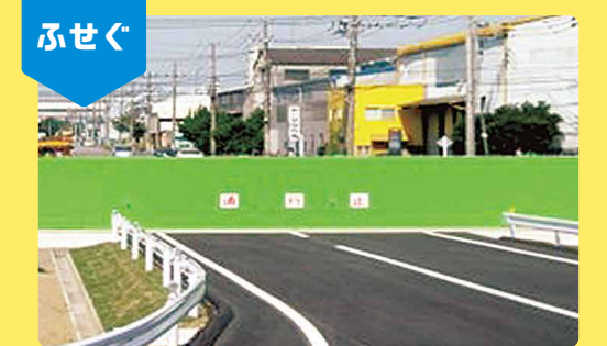
港・鉄鋼通りにある陸閘(ゲート)
