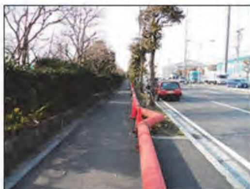
応急復旧(下水道仮配管)
