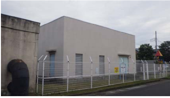
写真 2-1 当代島排水機場(外観)
