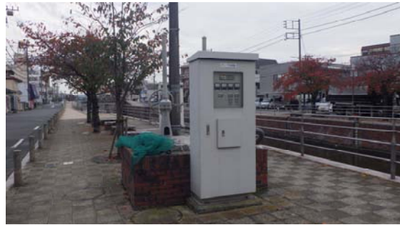
写真 2-4 重田用品店前ポンプ場
