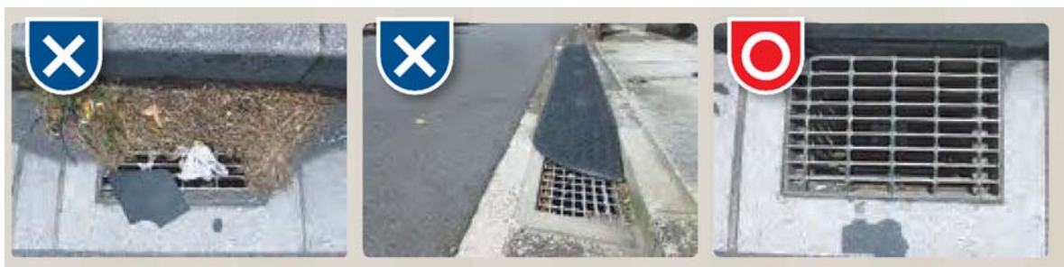
落ち葉・ごみなどでふさがれている排水溝
