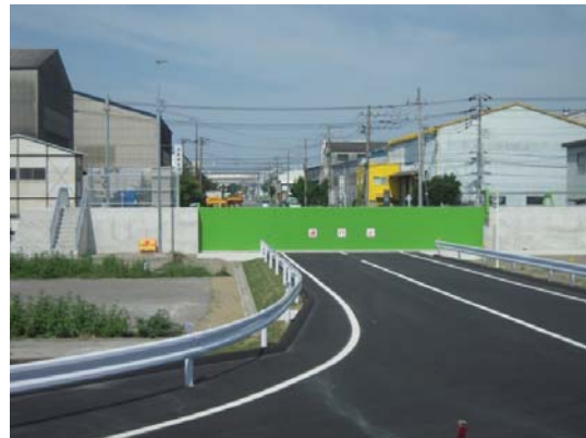
写真 2-6 港・鉄鋼通り陸閘
