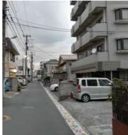
商店街では、中層のマンション建設が見られ始めている。
