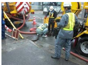
清掃車による土砂吸入作業
