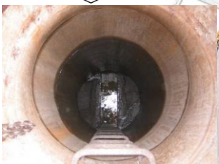
ポンプ設置による応急処置状況
