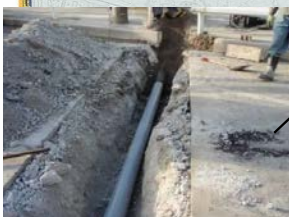
応急的なバイパス管設置
