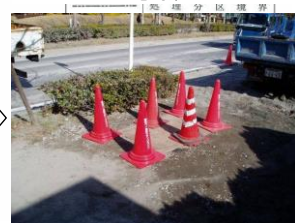
マンホール撤去後の安全対策状況
