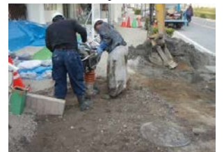
道路陥没応急復旧後
