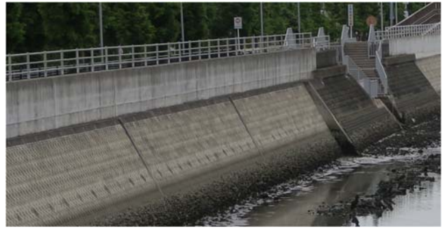
写真 4.16 ②東日本大震災後、災害復旧工事実施箇所
