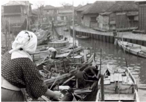
境橋付近の板張りの曲線部
