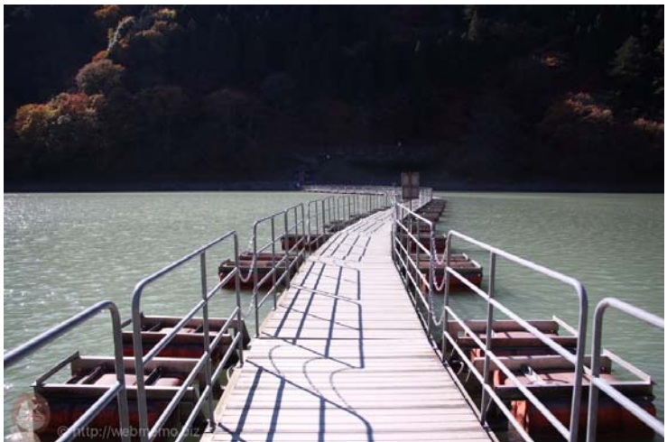
写真 4.12 発泡スチロール製の浮き橋（東京都・奥多摩湖）
