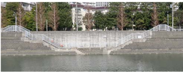
写真 4.17 ③消防用水利として整備された 水辺アクセス箇所。
