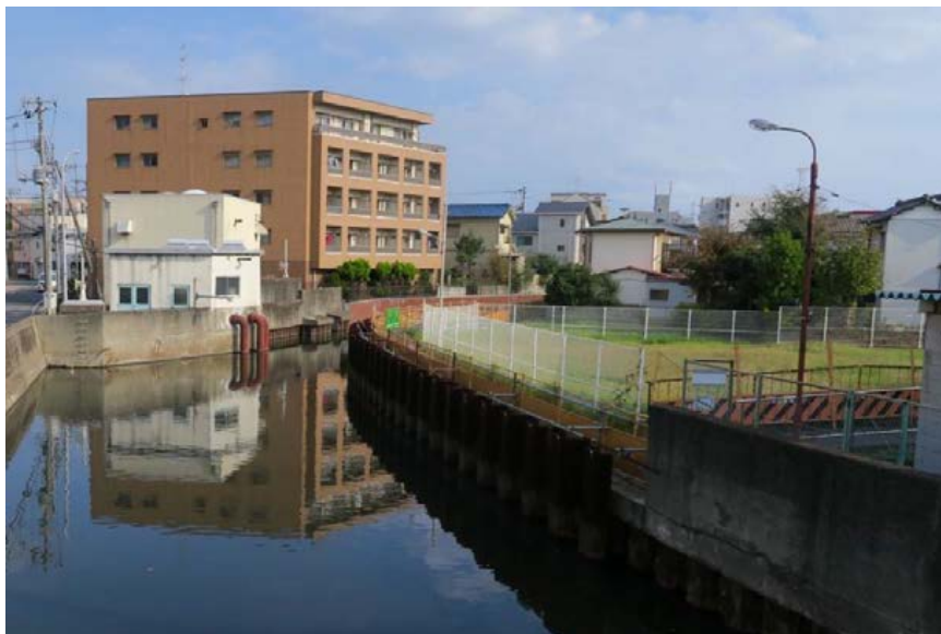
写真 4.5 ①整備中の防災広場予定地
