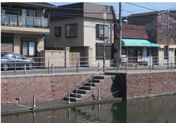
写真 4.9 ②レンガで装飾された擁壁
