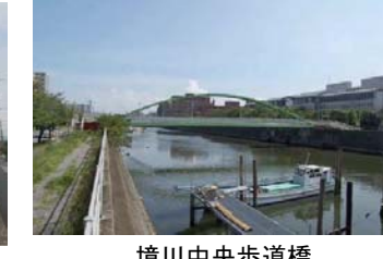
境川中央歩道橋
