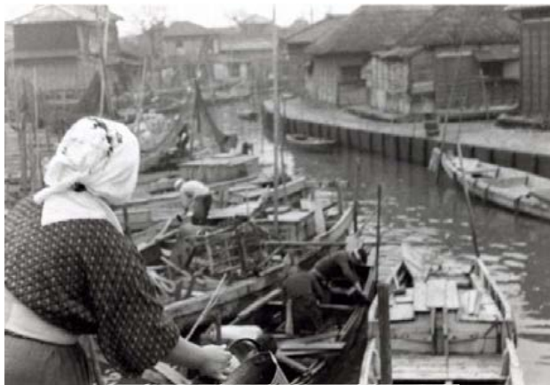
境橋付近の板張りの曲線部
