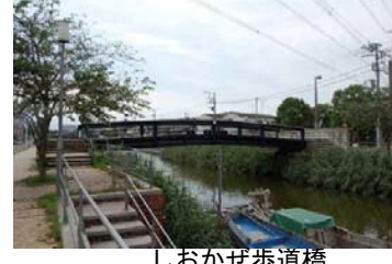
しおかぜ歩道橋
