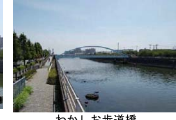
わかしお歩道橋
