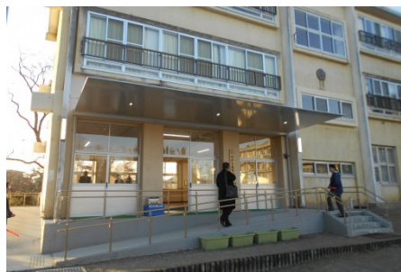
利府支援学校塩釜校の玄関に設置されているスロープ
