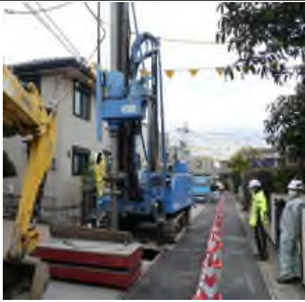
(道路部：機械式攪拌工法)
