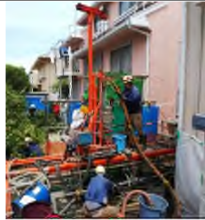
(宅地部：高圧噴射攪拌工法)
