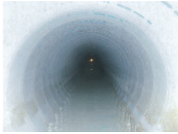
(埋設管の更生)
