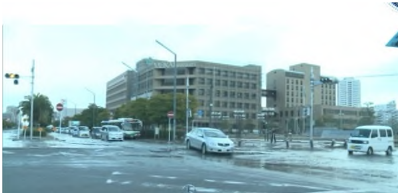
写真-1 幹線道路の被害写真
