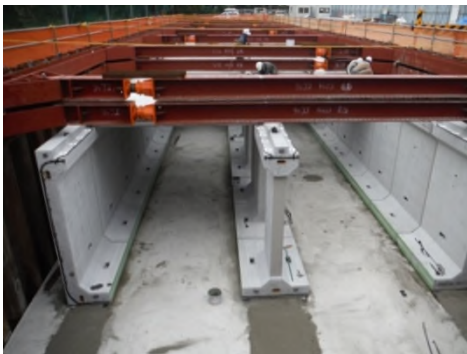
写真-2 雨水貯留施設の設置状況
