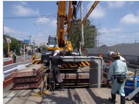
写真-2 雨水貯留施設の設置状況
