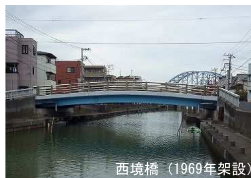
写真－1.2 20年後に50年を経過する橋梁
