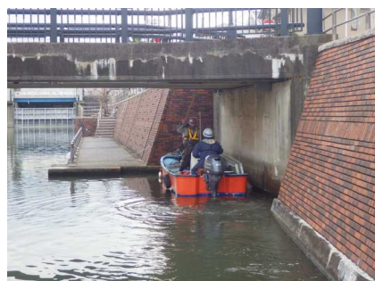
写真-4.2 点検状況（船上）
