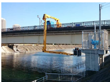
写真-4.1 点検状況（点検車）
