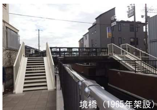
写真－1.1 建設後50年を経過する橋梁
