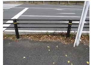
南西方向から見る
