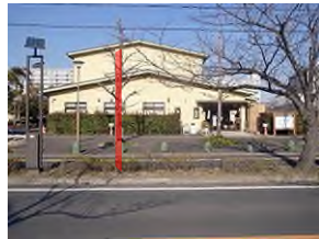
南西方向より見る
