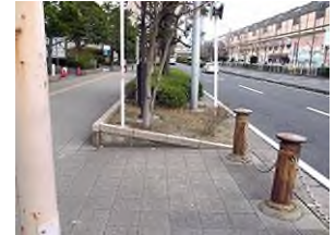
南西方向から見る
