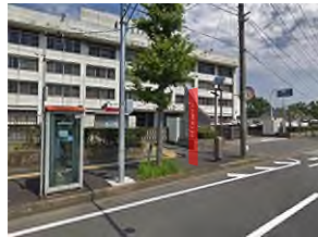
南方向車道より見る
