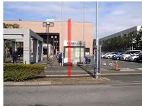
南西方向より見る
