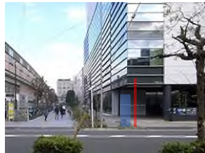
南西方向より見る
