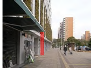
南西方向から見る
