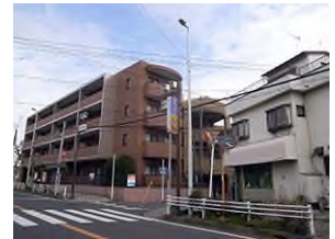
南西方向から見る
