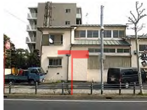
西方向から見る
