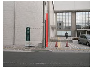
西方向から見る
