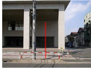
南方向から見る
