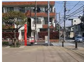
西方向から見る
