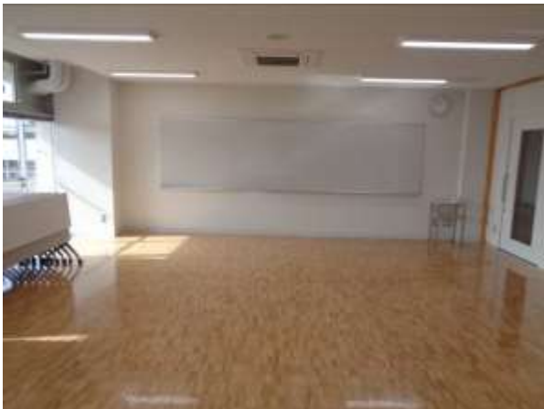
後方から（何も設置していない状態）
