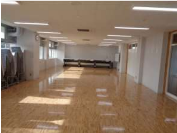
後方から（何も設置していない状態）
