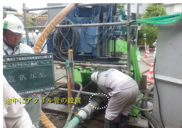
写真 2-4 排泥状況目視（管先）
