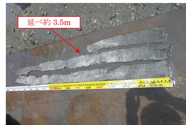
写真 1-10 埋設物の外観
