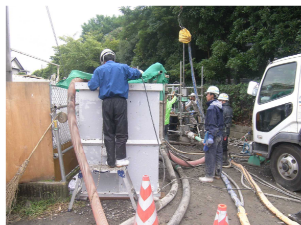
写真 2-5 排泥状況目視（排出タンク）
