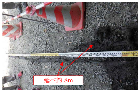
写真 1-6 埋設物の外観
