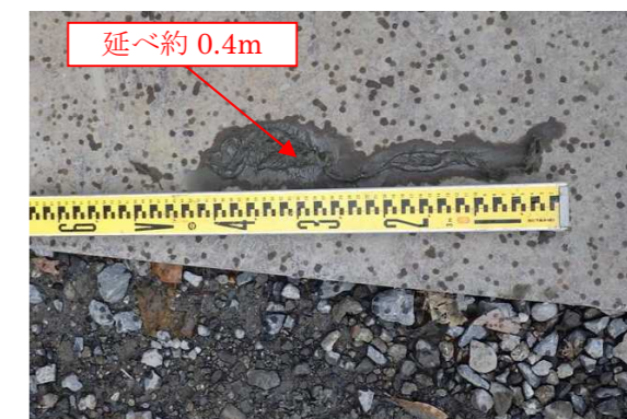
写真 1-12 埋設物の外観
