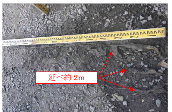
写真 1-8 埋設物の外観
