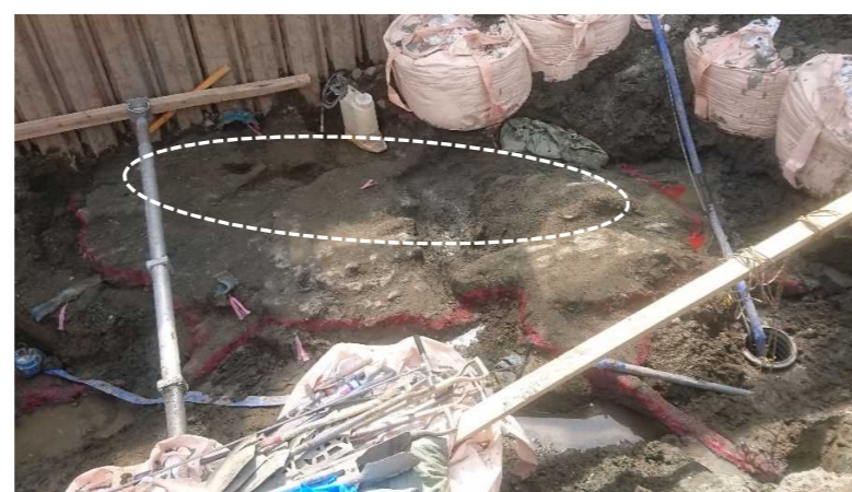
写真2-10 改良体掘り出し状況 (No. 3)
