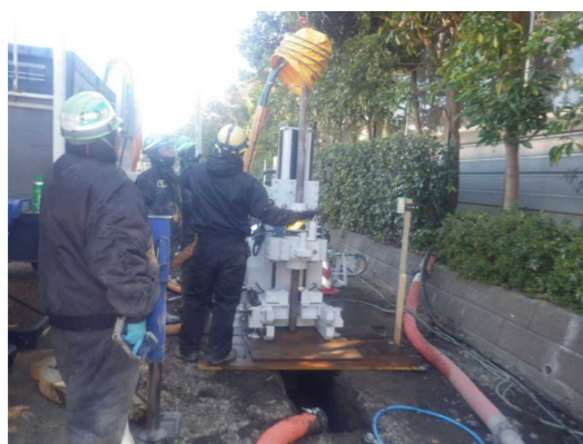
写真 1-5 改良体の施工状況
