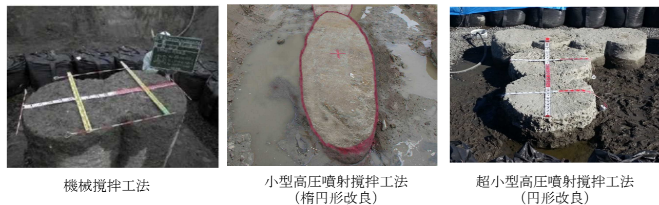
写真 1-2 各工法による地盤改良体外観 (例)
