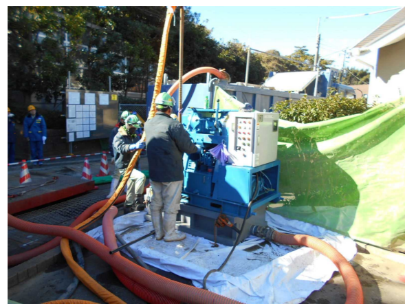
写真 1-3 円形改良体の施工状況
