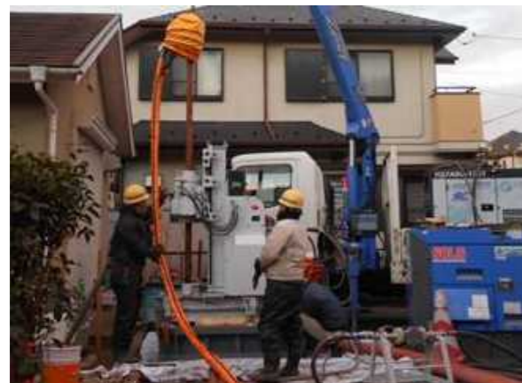
写真 1-4 楕円形改良体の施工状況
