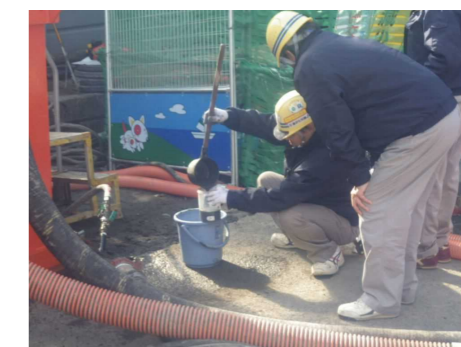
写真 1-16 排泥性状・混入物確認
