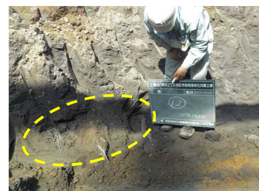
写真 2-3 ドレーン、シート (水平方向)
