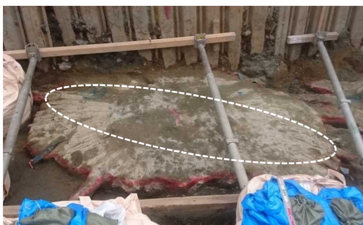
写真2-13 改良体掘り出し状況 (No. 6)
