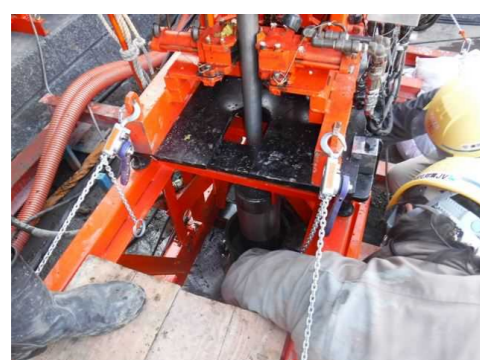
写真 1-11 コアチューブ取り付け
