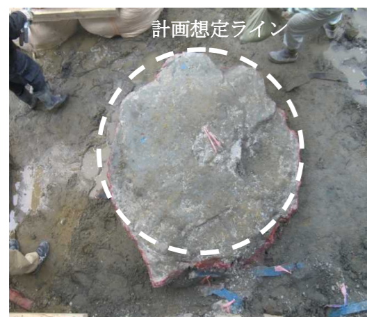
写真2-9 改良体掘り出し状況 (No. 1)
