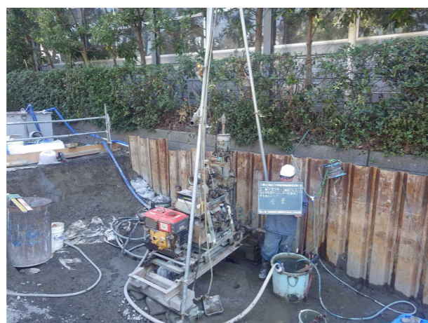
写真2-14 コアボーリング状況
