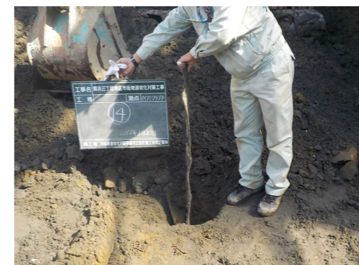
写真 2-1 ドレーン材 (鉛直方向)
