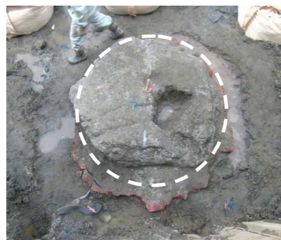
写真2-12 改良体掘り出し状況 (No. 5)
