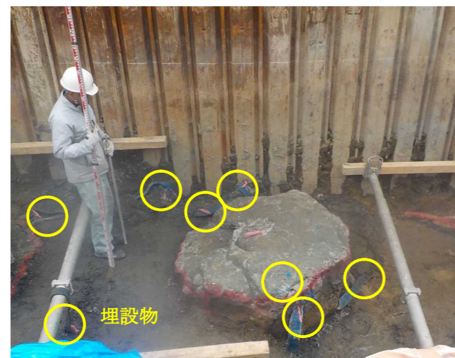
写真2-19 改良体と埋設物（円形 No. 1）
