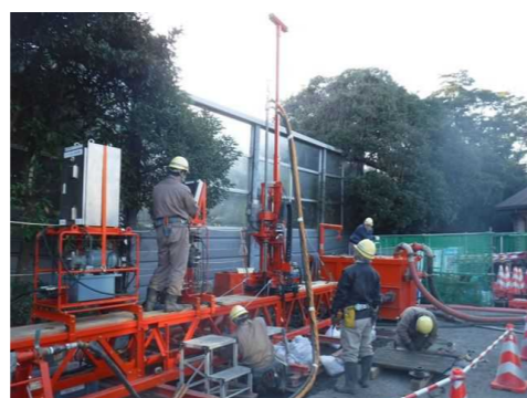
写真 1-12 事前削孔状況
