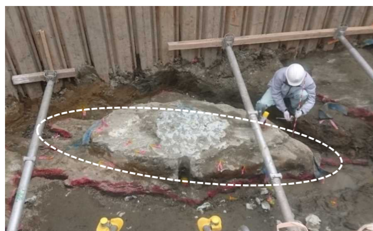
写真2-11 改良体掘り出し状況 (No. 4)
