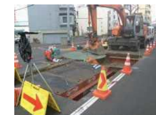
道路覆工板の設置イメージ
