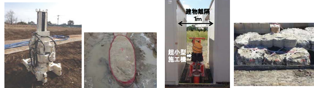
写真-2.1 小型高圧噴射攪拌工法 (円・楕円形) 写真-2.2 超小型高圧噴射攪拌工法 (円形)
