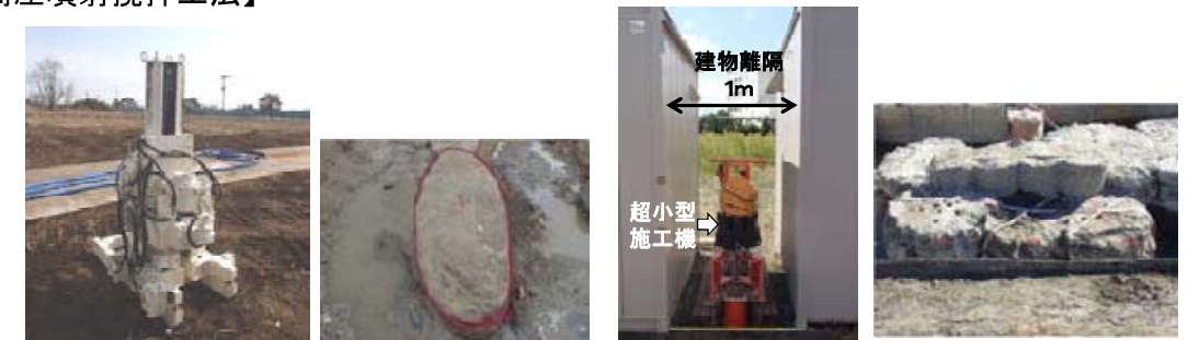
写真-2.2 小型高圧噴射攪拌工法(円・楕円形)
