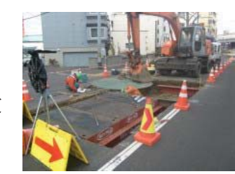
道路覆工板の設置イメージ
