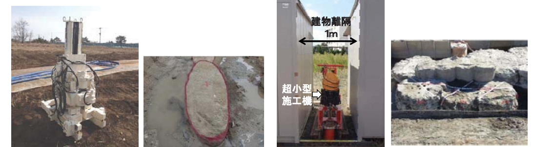
写真-2.2 小型高圧噴射攪拌工法(円・楕円形) 写真-2.3 超小型高圧噴射攪拌工法(円形)
