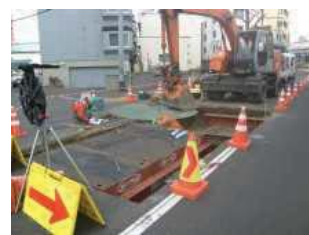
道路覆工板の設置イメージ
