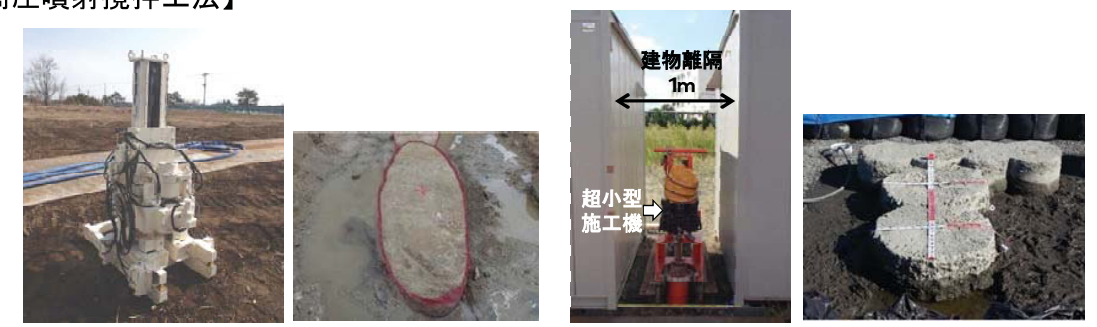
写真-2.2 小型高圧噴射攪拌工法(円・楕円形)
