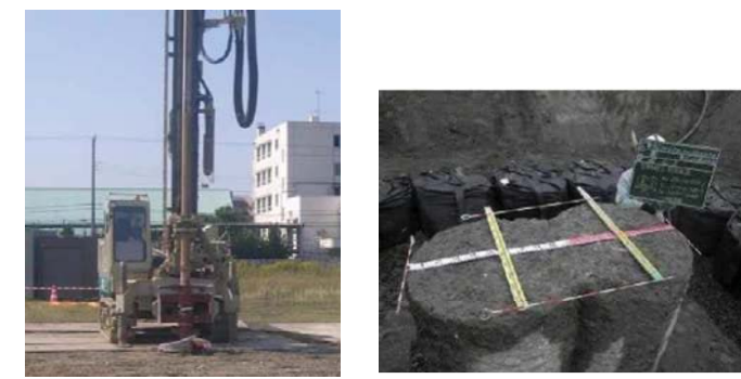
写真-2.1 機械攪拌工法 (円形)
