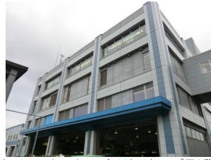
クリーンセンター（リサイクルプラザ）
