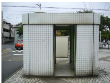
しおかぜ緑道公衆トイレ （堀江1丁目）
