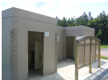
高洲地区西側緑地（中央区域） トイレ
