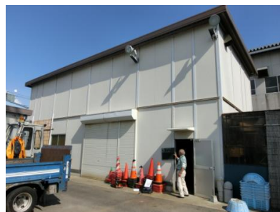
北栄水防倉庫
