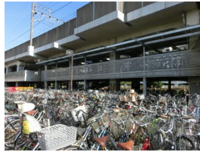
新浦安駅第2自転車駐車場(増築棟)
