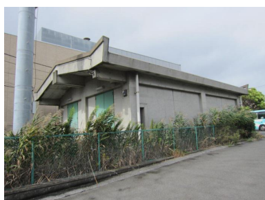
東野防災備蓄倉庫
