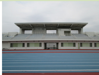
陸上競技場（スタンド棟）
