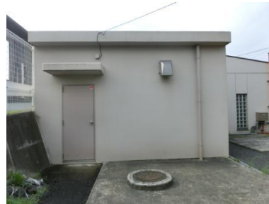
船込川第2排水機場
