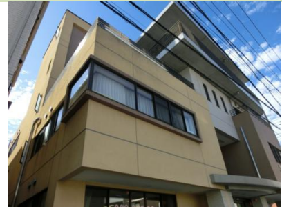
浦安駅前保育園・浦安駅前高齢者デイサービスセンター
