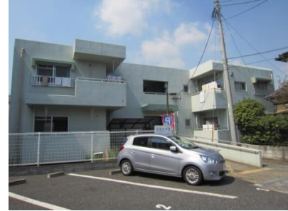
猫実第4市営住宅
