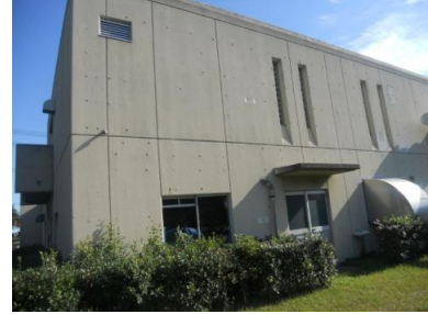
舞浜ポンプ場
