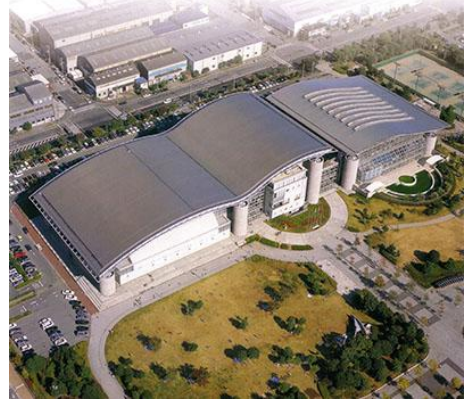
運動公園総合体育館
