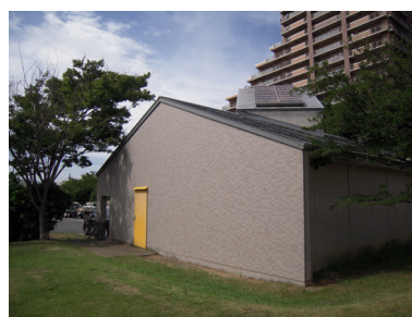
高洲中央公園防災備蓄倉庫
