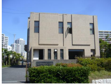
高洲ポンプ場
