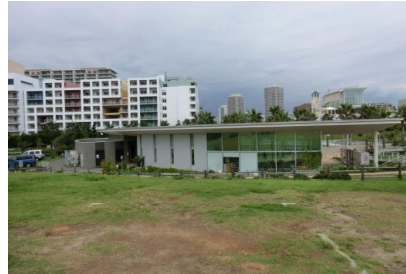
総合公園管理棟
