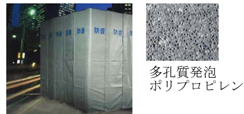
写真-4.5.2 ノイズソーバーの騒音対策イメージ
