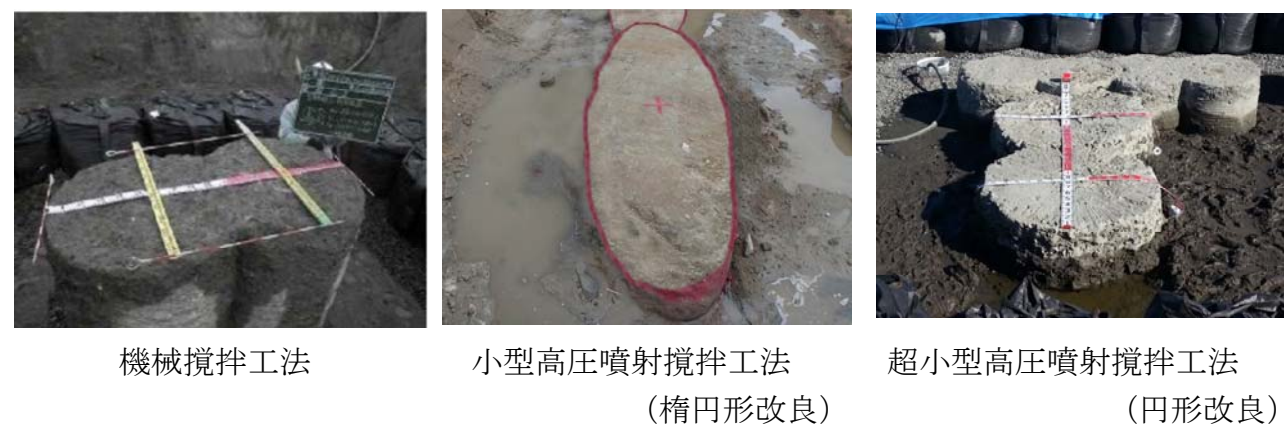
写真-4.1.2 各工法における地盤改良体外観（例）
