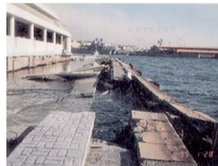
図-3.1.4 格子状地盤改良で液状化対策されていた建物 (阪神大震災時に被害なし、隣接する無対策の岸壁は液状化により崩壊)
