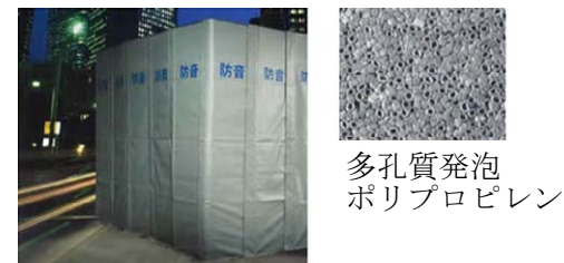
写真-5.2 ノイズソーバーの騒音対策イメージ
