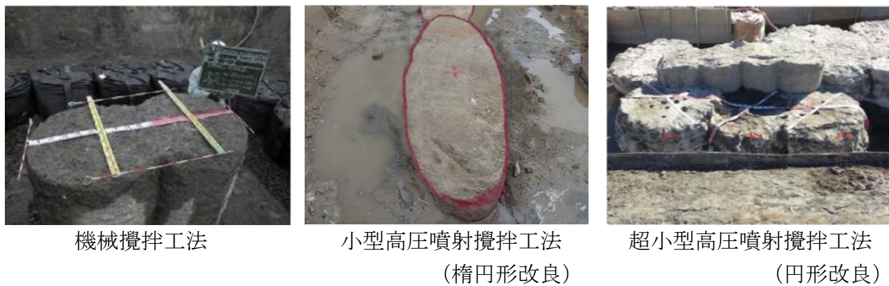
写真-1.2 各工法における地盤改良体外観（例）
