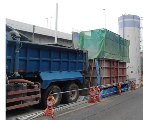
写真-5.3 搬出状況（仮置きタンクとタンク車の例）
