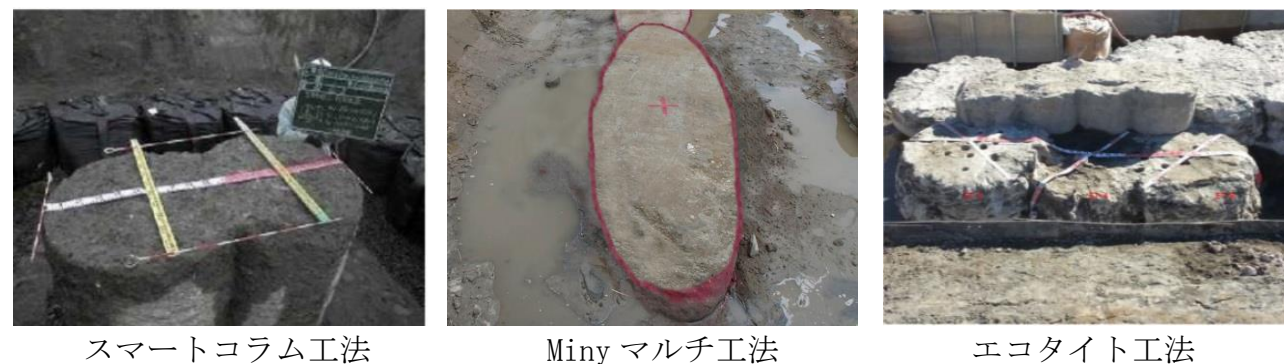
写真-1.2 各工法における地盤改良体外観（例）
