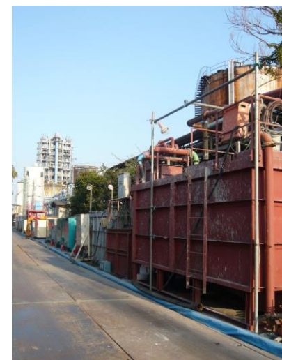
写真-5.1 仮置きタンク（排泥槽）の設置例 （設置しない場合もあります）
