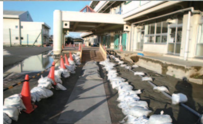
応急復旧工事が急ピッチで行われました
