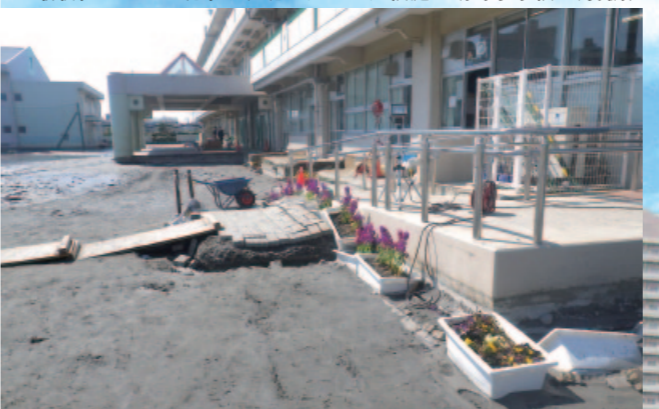
液状化で地盤が沈下し、泥がたまった校庭—明海小学校3月撮影—
