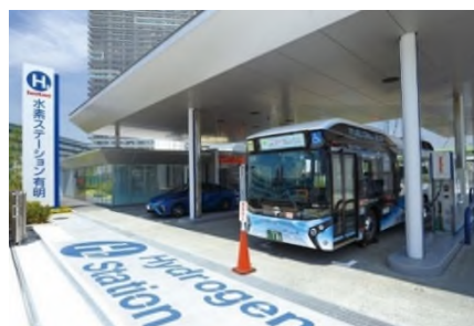
水素ステーション
