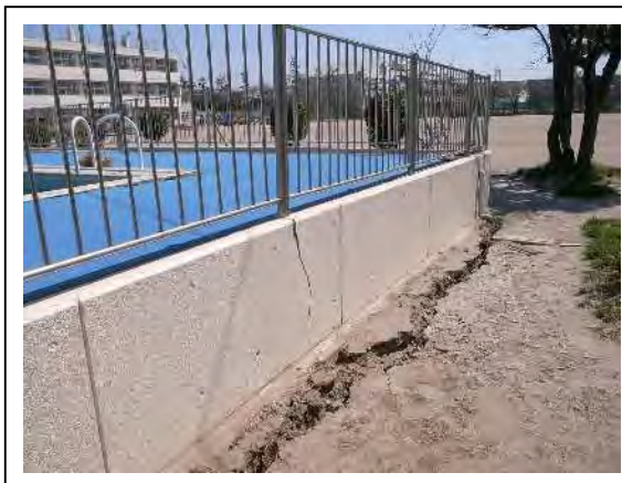
見明川小学校 プール周囲
