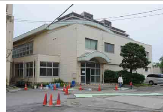
屋内運動場棟（摩擦杭、地盤改良なし）
