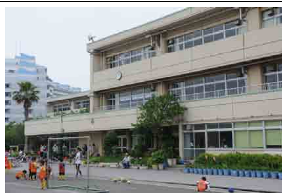
校舎棟（支持杭、バイプロフローテーション）
