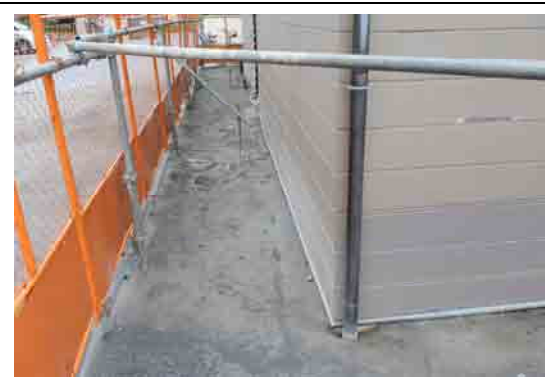
日の出小学校増設校舎棟（直接基礎、地盤改良なし）
