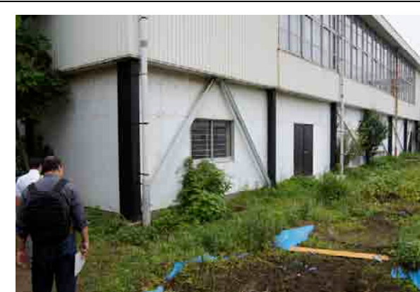
屋内運動場棟（摩擦杭、パイプフロロテーション）
