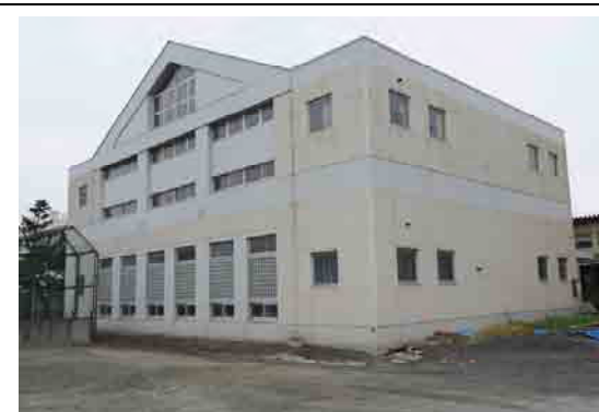
見明川中学校武道場棟（摩擦杭、地盤改良なし）
