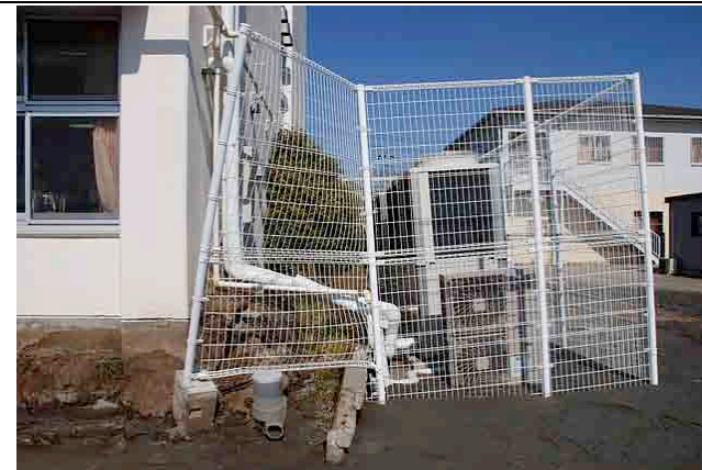
見明川小学校校舎（支持杭、地盤改良なし）
