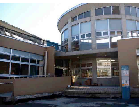
高洲小学校校舎棟（支持杭、地盤改良なし）
