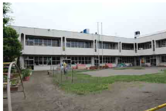
見明川幼稚園校舎棟（摩擦杭、地盤改良なし）
