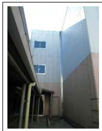
日の出中学校 エレベーター塔
