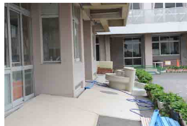
明海幼稚園校舎（摩擦杭、地盤改良なし）
