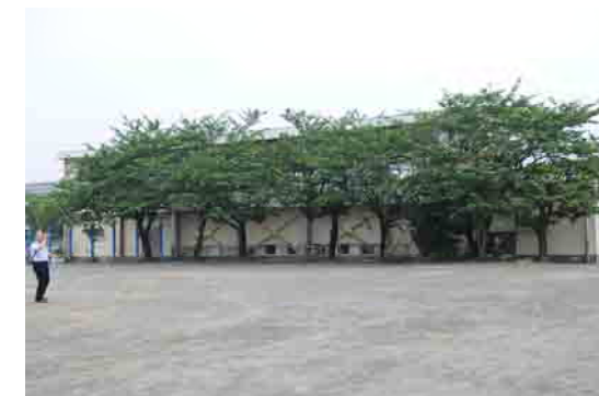
屋内運動場棟（摩擦杭、サンドコンパクションパイル）
