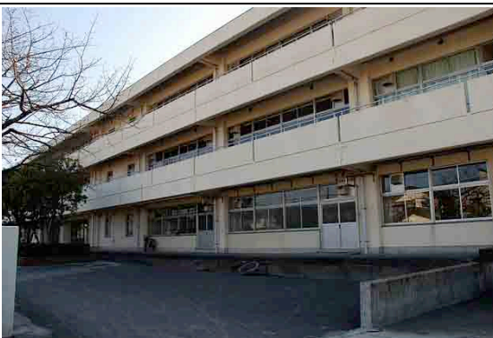
見明川中学校校舎棟（支持杭、地盤改良の有無：確認中）
