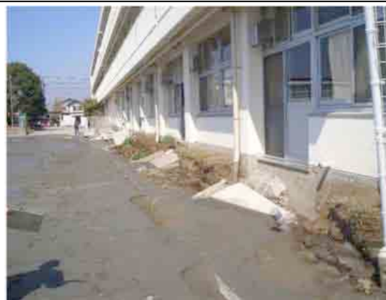
見明川小学校校舎棟（支持杭、地盤改良なし）
