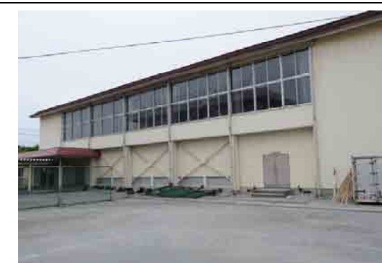
屋内運動場棟（摩擦杭、地盤改良の有無：確認中）
