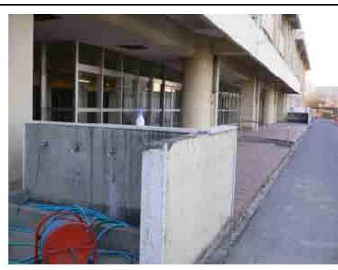
入船中学校校舎棟（支持杭、バイプロフローテーション）
