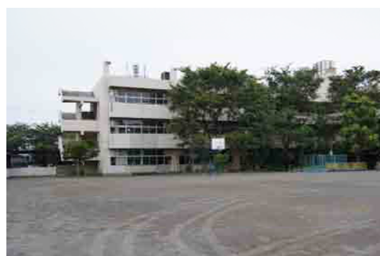
富岡小学校校舎（支持杭、サンドコンパクションパイル）
