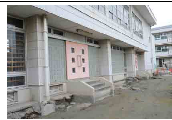
屋内運動場棟（摩擦杭、地盤改良なし）
