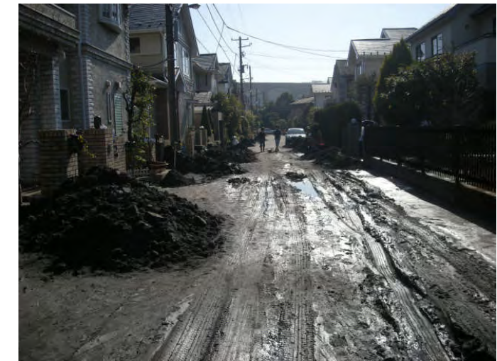
道路被害大（被災程度例）
