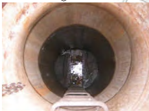
ポンプ設置による応急処置状況
