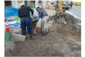
道路陥没応急復旧後
