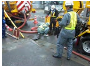
清掃車による土砂吸入作業
