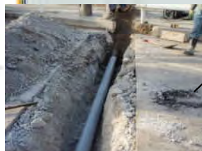
応急的なバイパス管設置
