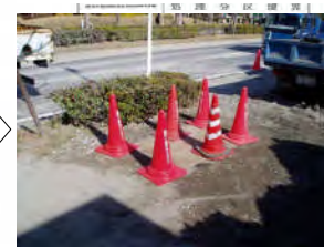
マンホール撤去後の安全対策状況
